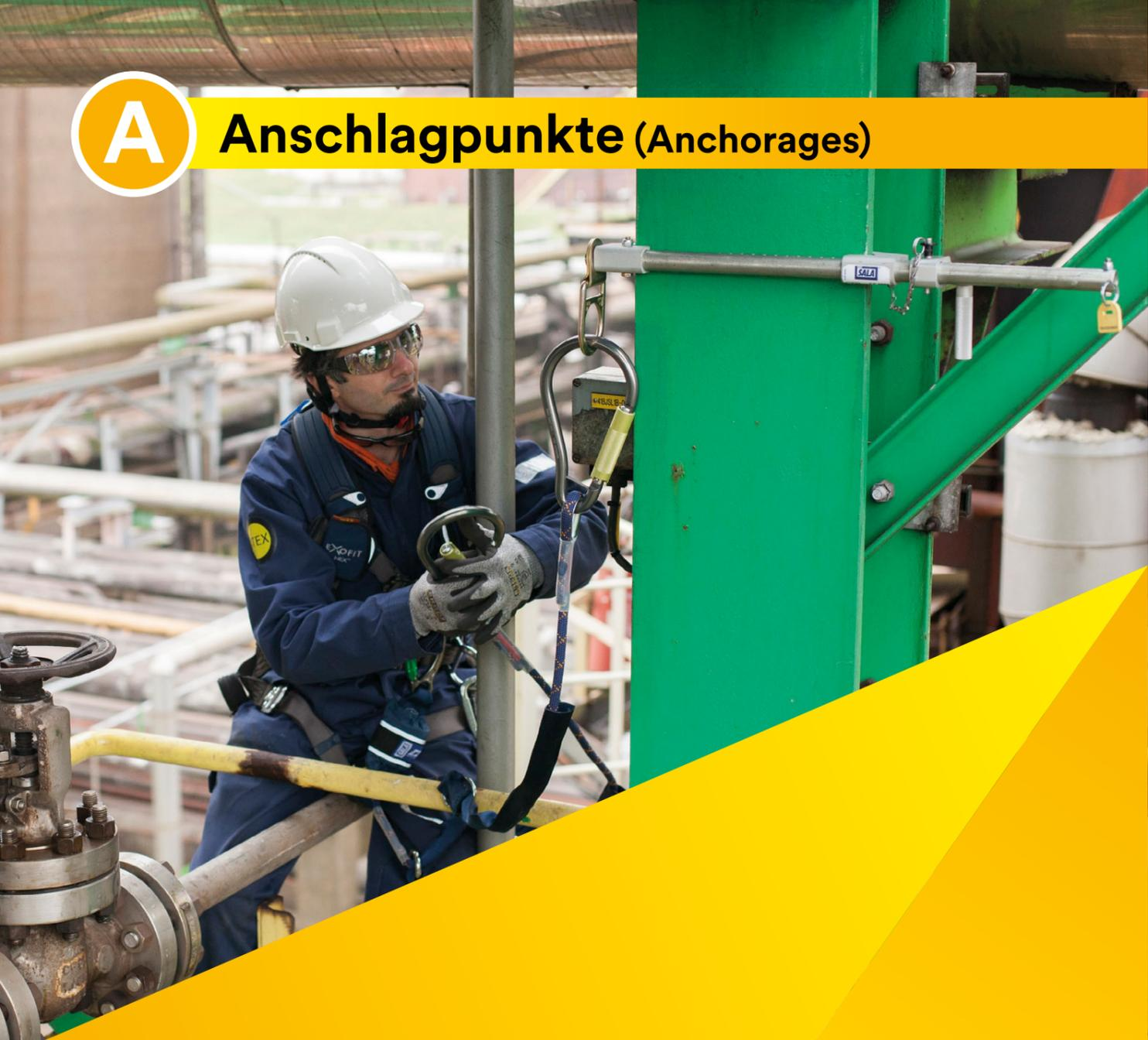
Anschlagpunkte sind sichere Befestigungspunkte. Anschlaghilfsmittel variieren je nach Branche, Tätigkeit, Anlagen- und Gebäudetyp. Sie müssen in der Lage sein, den Kräften standzuhalten, die bei einem Absturz, bei seilunterstützten Arbeiten oder der Rettung wirken.
